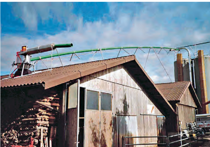
35 Meter lange Transportleitung aus Kunststoff mit Turbozyklon auf dem Dach.
