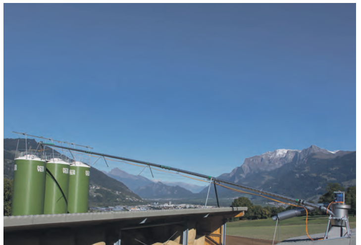
32 Meter lange Transportleitung aus Edelstahl mit Turbozyklon auf dem Dach.
